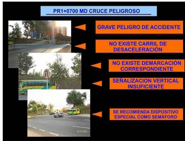
Figura 7. Señalización de tránsito deficiente.
