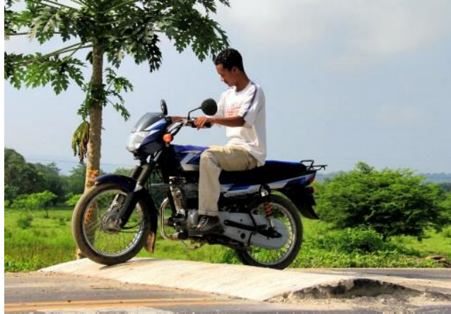
Figura 6. Resalto físico construido por la comunidad en Malagana.
