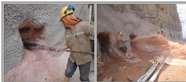
Figura 5. Ensayo de estanqueidad y limpieza de la perforación.
