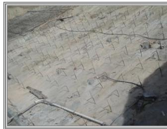
Figura 11. Instalación de barras de anclaje.
