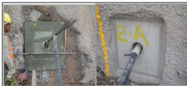
Figura 6. Construcción de placa base de apoyo.
