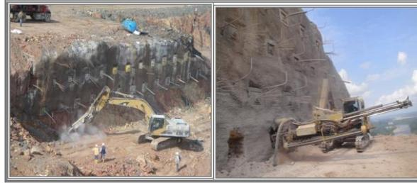
Figura 4. Perfilación del talud y perforación de barrenos.
