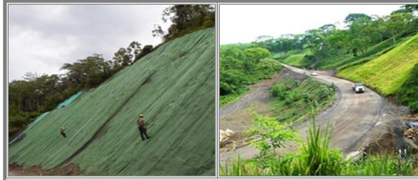
Figura 12. Instalación de biomantos y cobertura vegetal.
