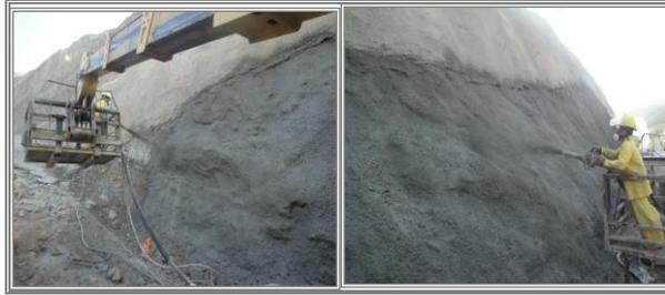
Figura 2. Aplicación de concreto lanzado neumáticamente mediante maquina impulsora.
