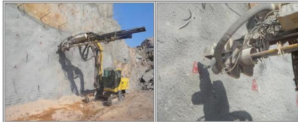
Figura 9. Marcación y perforación de barrenos para la instalación de pernos de anclaje.
