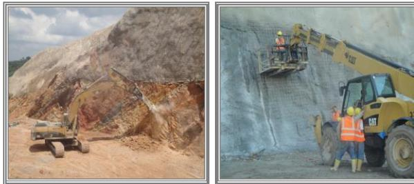
Figura 1. Perfilación del corte de talud y colocación de acero de refuerzo con malla electrosoldada.
