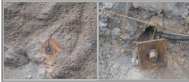
Figura. 10. Instalación de la estructura del perno y refuerzo adicional.
