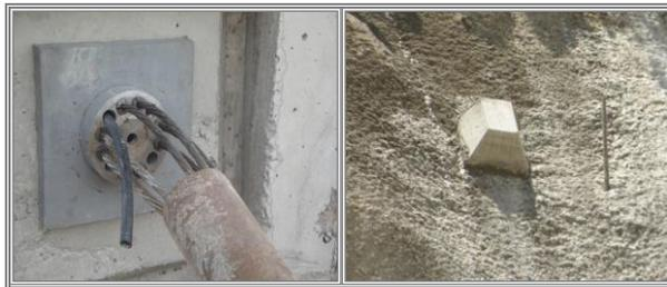
Figura 8. Detalle y terminado de la cabeza de tensionamiento del tendón.
